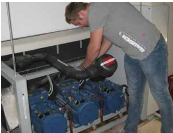
Abb. 5: Anbringen der Kennzeichnung
