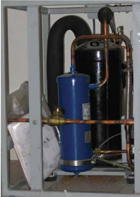
Abb. 4: Copeland-Scrollverdichter für die Tiefkühlung
